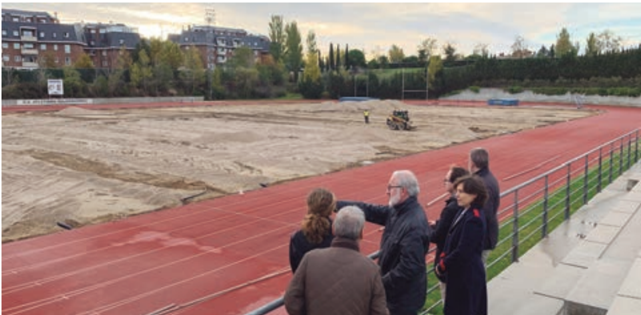
Nuestros concejales visitando las obras de “Valle del Arcipreste”
